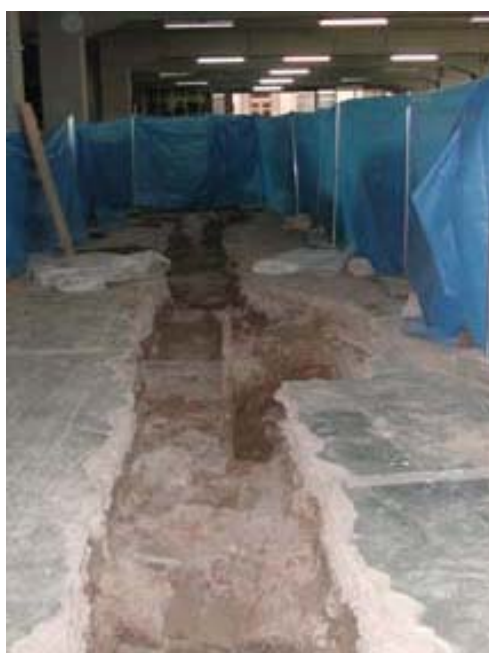
Vista general del sondeig 100 un cop delimitades les estructures.
